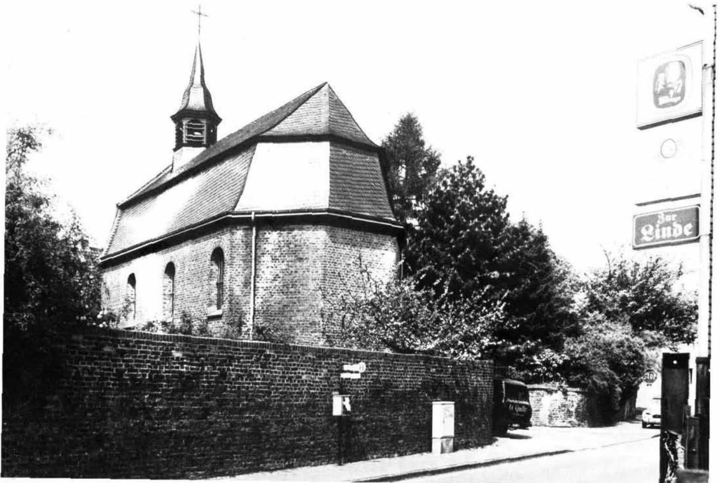
„Barockkapelle in Brühl-Badorf (von Südosten)“
